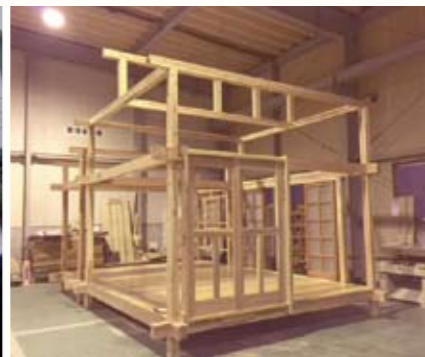
研修生が加工した日本の伝統工法による軸組
